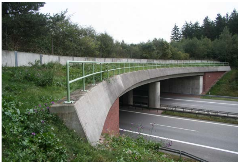
Talbrücke bei Radegast/A20 (oben) und Grünbrücke bei Beidersdorf/A20 (unten).
