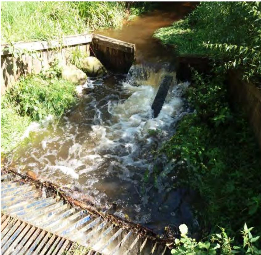
**Abbildung 11 Auslaufbauwerk im Verlauf der Stellau**
